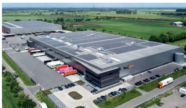
Luftaufnahme eines Vos-Logistics-Standorts mit moderner Lager- und Cross-Docking-Infrastruktur sowie Photovoltaikanlage
